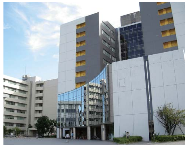
名古屋工業大学正面から2号館
